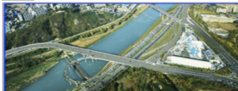
용비교~행당중간 도로 개설공사 Title of the construction project
